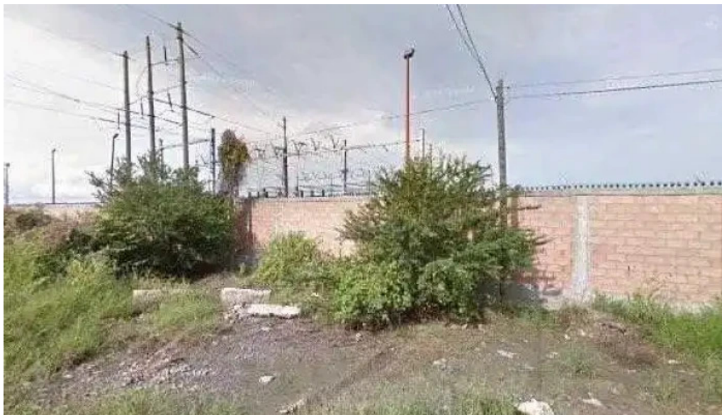
Subestacion electrica villa union precios
