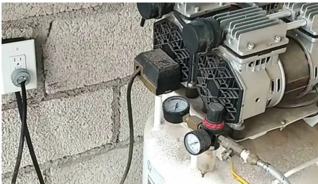
Electricidad y plomeria richy del propietario
