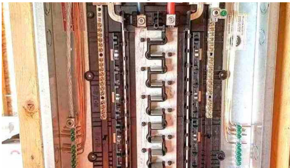
Electricidad y cctv eduherez tezontlalpa de zapata
