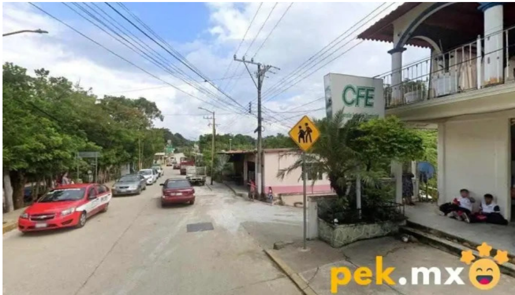
Comision federal de electricidad agencia jalapa de diaz san felipe jalapa de diaz
