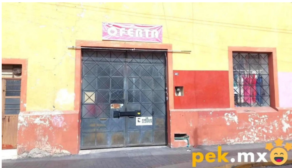
Cerrajería rr exterior
