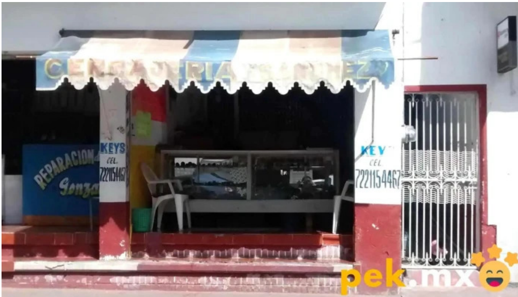
Cerrajería sánchez exterior
