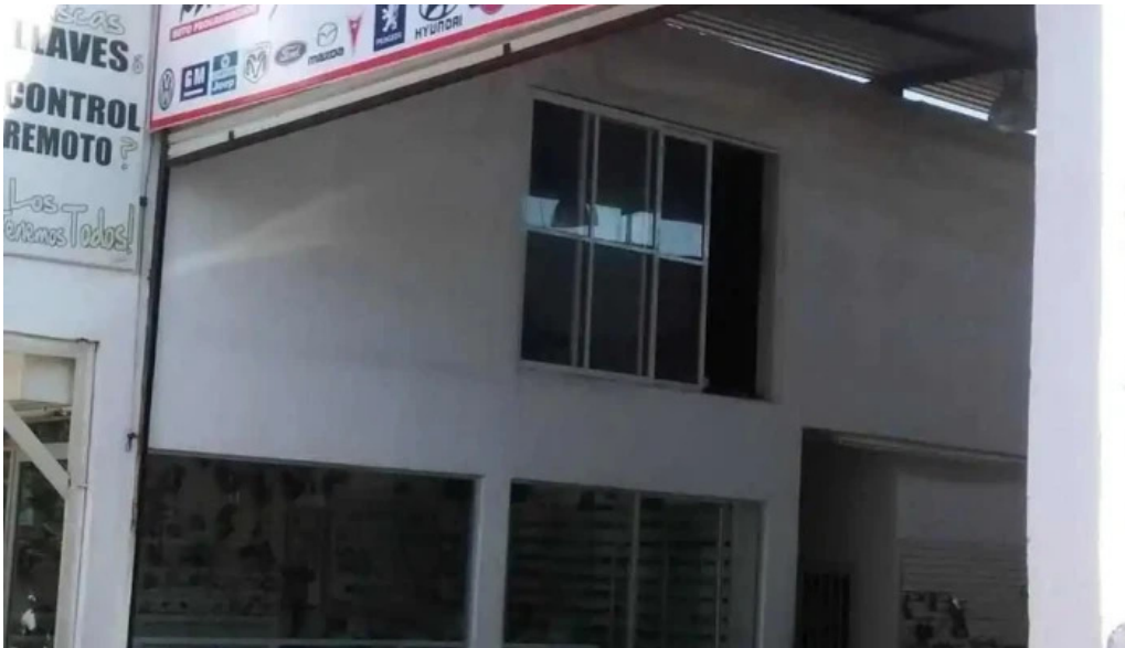
Cerrajería automotriz mg exterior
