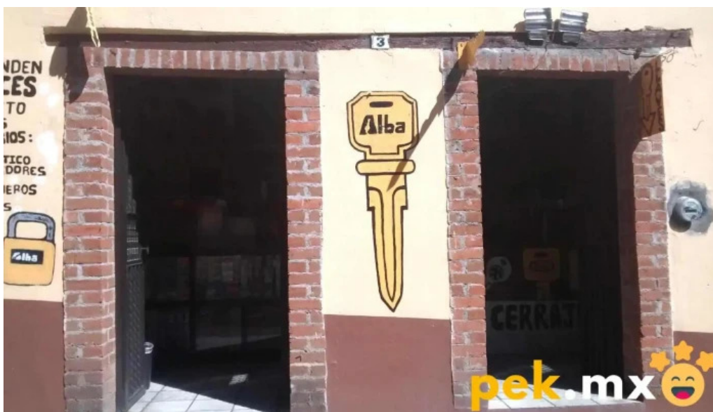
Cerrajería el oro exterior
