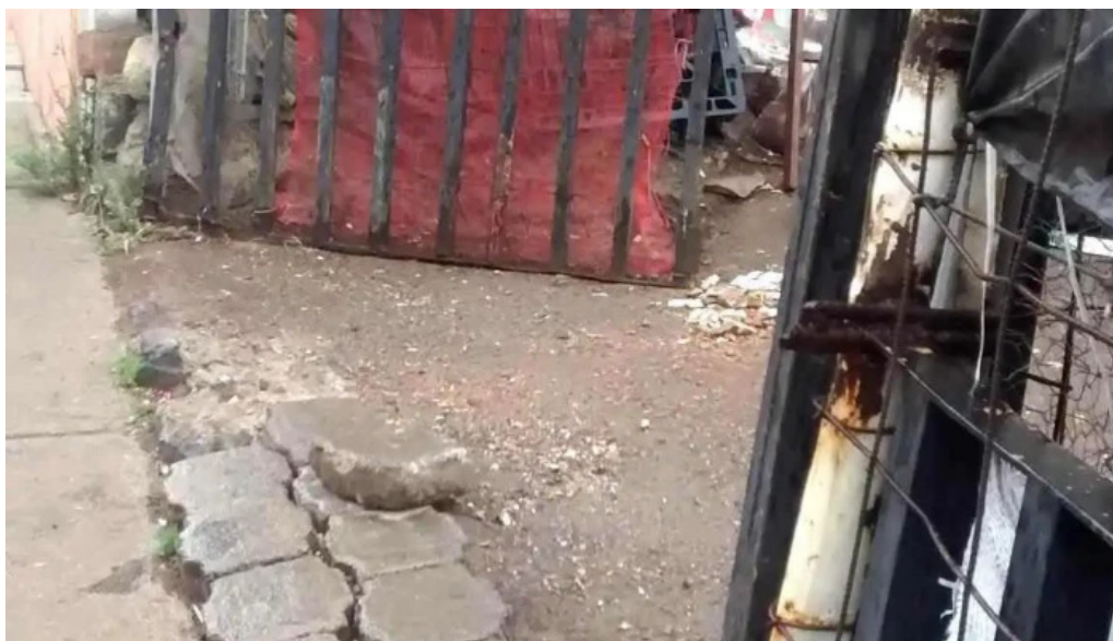
Centro de acopio edificio
