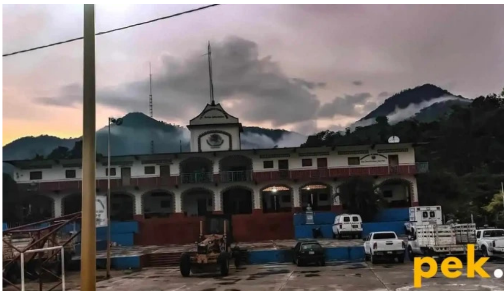
Edificio municipal de san juan lachao edificio
